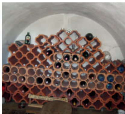
Aus liegenden Brunnenrohren und verputzt ist der Erdkeller bei Naturteich Sailer in Pöndorf.
