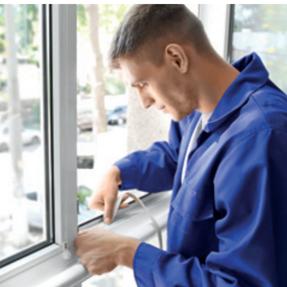
Mit Dichtungsbandern lassen sich Fenster kostengünstig sanieren.
