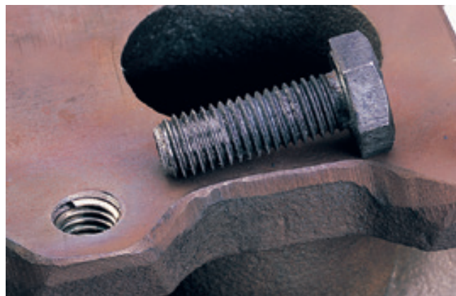
Korrektur mit einem Helicoil-Korrosionsschutz-Gewinde.
