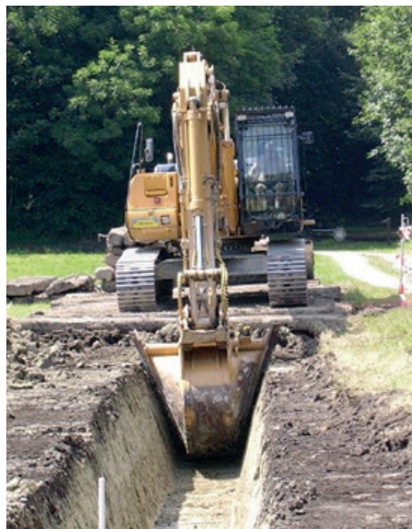
Raupenbagger schonen den Boden beim Arbeiten.
