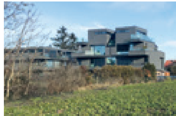
Für dieses Haus mit 22 Wohnungen mussten 30 alte Nadelbäume gefällt werden.
