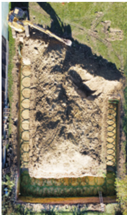
Die geothermischen Leitungen werden vergraben. Die Wärmepumpe steht in der Größe eines Kühlschranks im Technikraum. Bei Erdwärmelösungen gibt es keine Wärmepumpentechnik außerhalb vom Gebäude.
