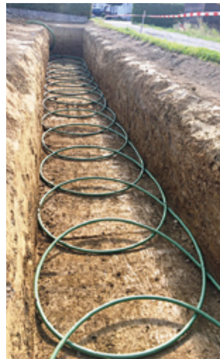
Die geothermischen Leitungen werden vergraben. Die Wärmepumpe steht in der Größe eines Kühlschranks im Technikraum. Bei Erdwärmelösungen gibt es keine Wärmepumpentechnik außerhalb vom Gebäude.
