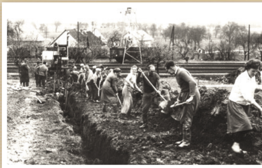
Wasserleitungsbau im SV Abwinden, Oberösterreich, im Jahr 1964.
