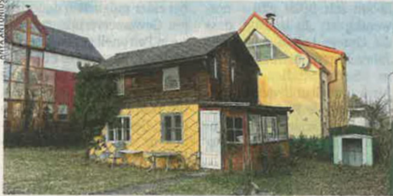
Einige der alten Häuser warten auf ihren Abriss.
